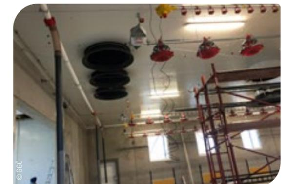
Abb. 95: Die Futterlinien oder -kreise werden an der Stalldecke mit Seilzügen und Winden montiert.
