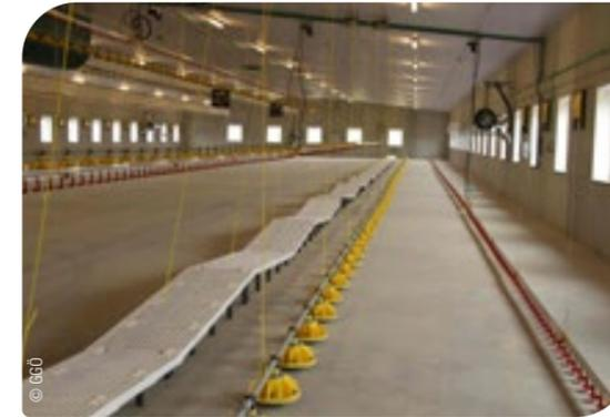
Abb. 97: Futter- und Wasserlinien werden im Stall abwechselnd montiert, wobei an der Wand mit einer Wasserlinie begonnen wird.
