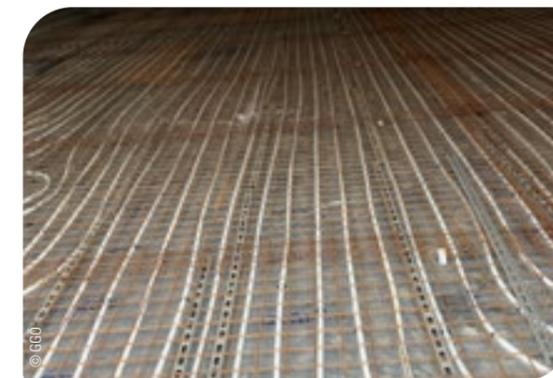
Abb. 98: Fußbodenheizung
