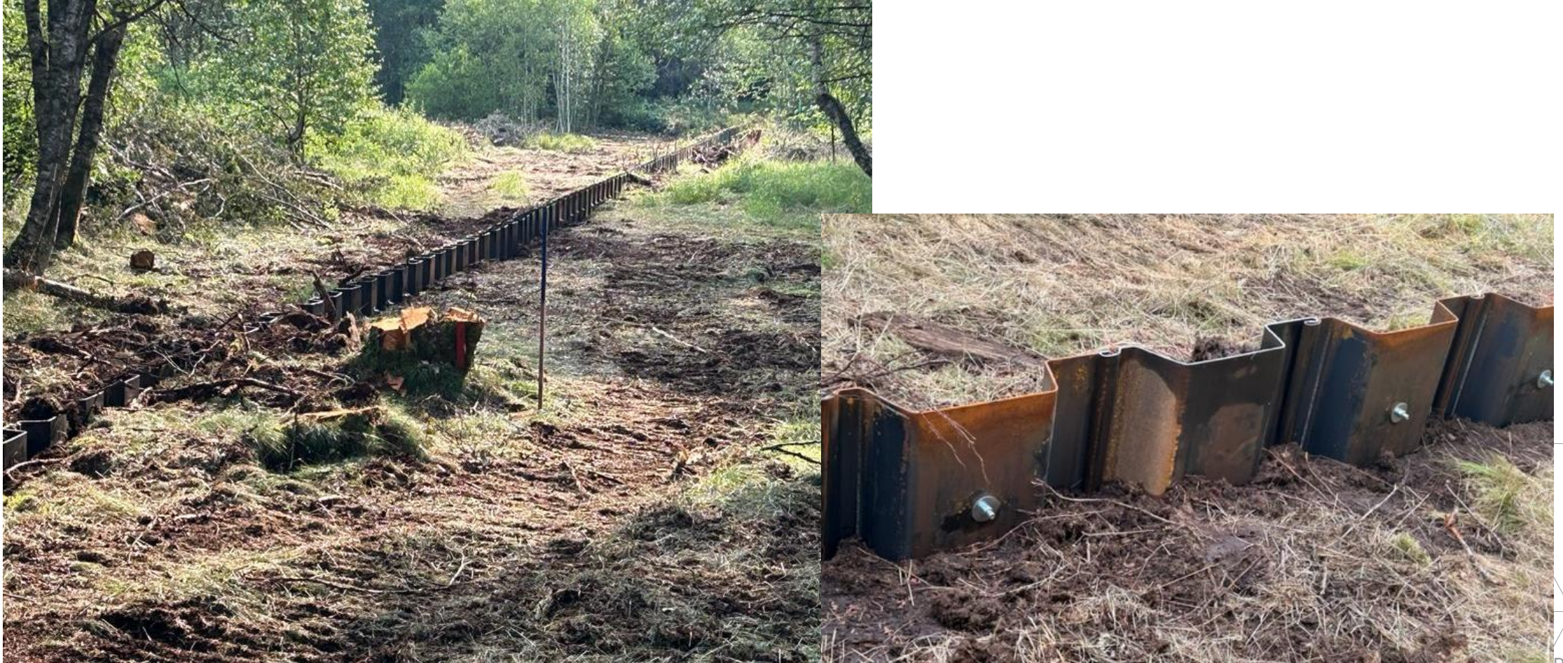
Stahlspundwand Rotes Moor (Fa. SSH – Spundwand- & Stahlhandel GmbH)
