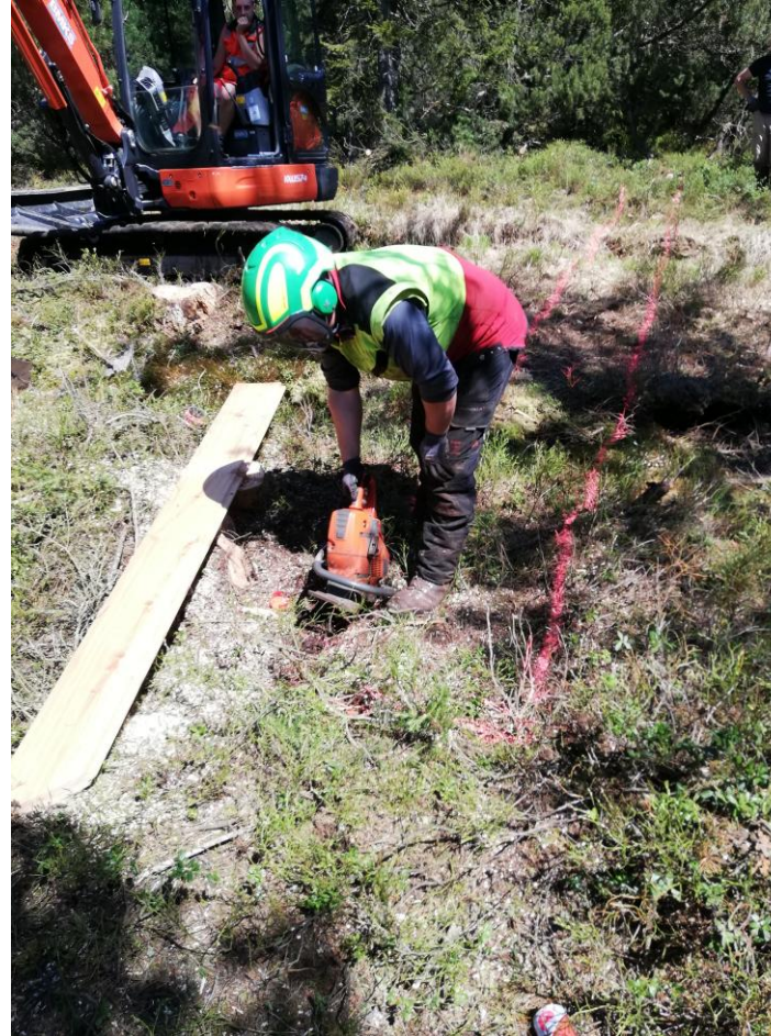
Anschnitt mit Motorsäge
