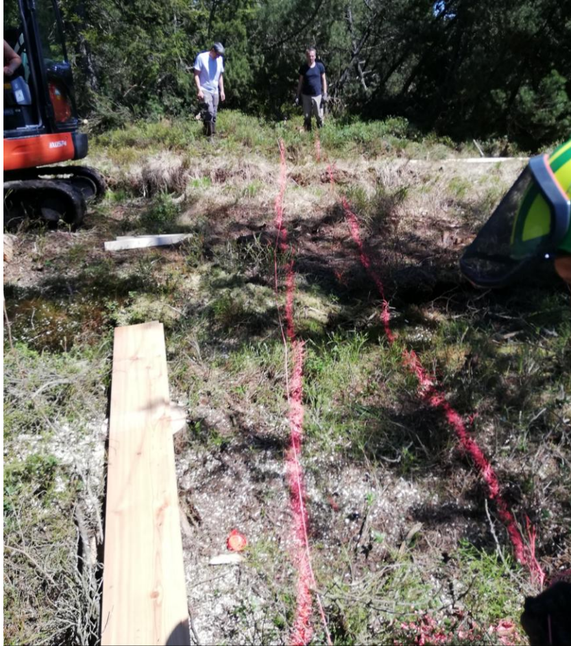
Ausstecken im Gelände
