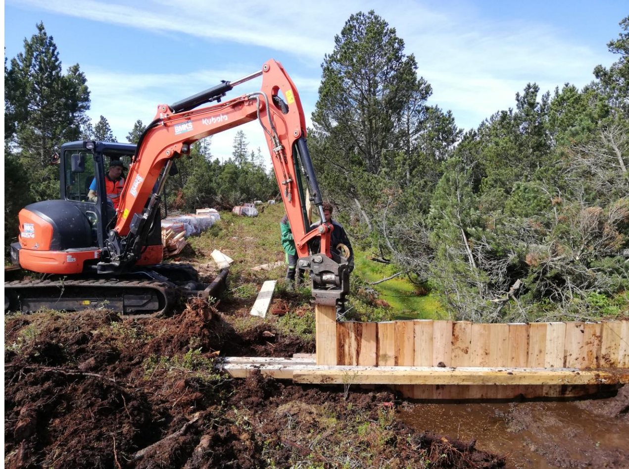
Drücken der Lärchenbretter mittels Bagger
