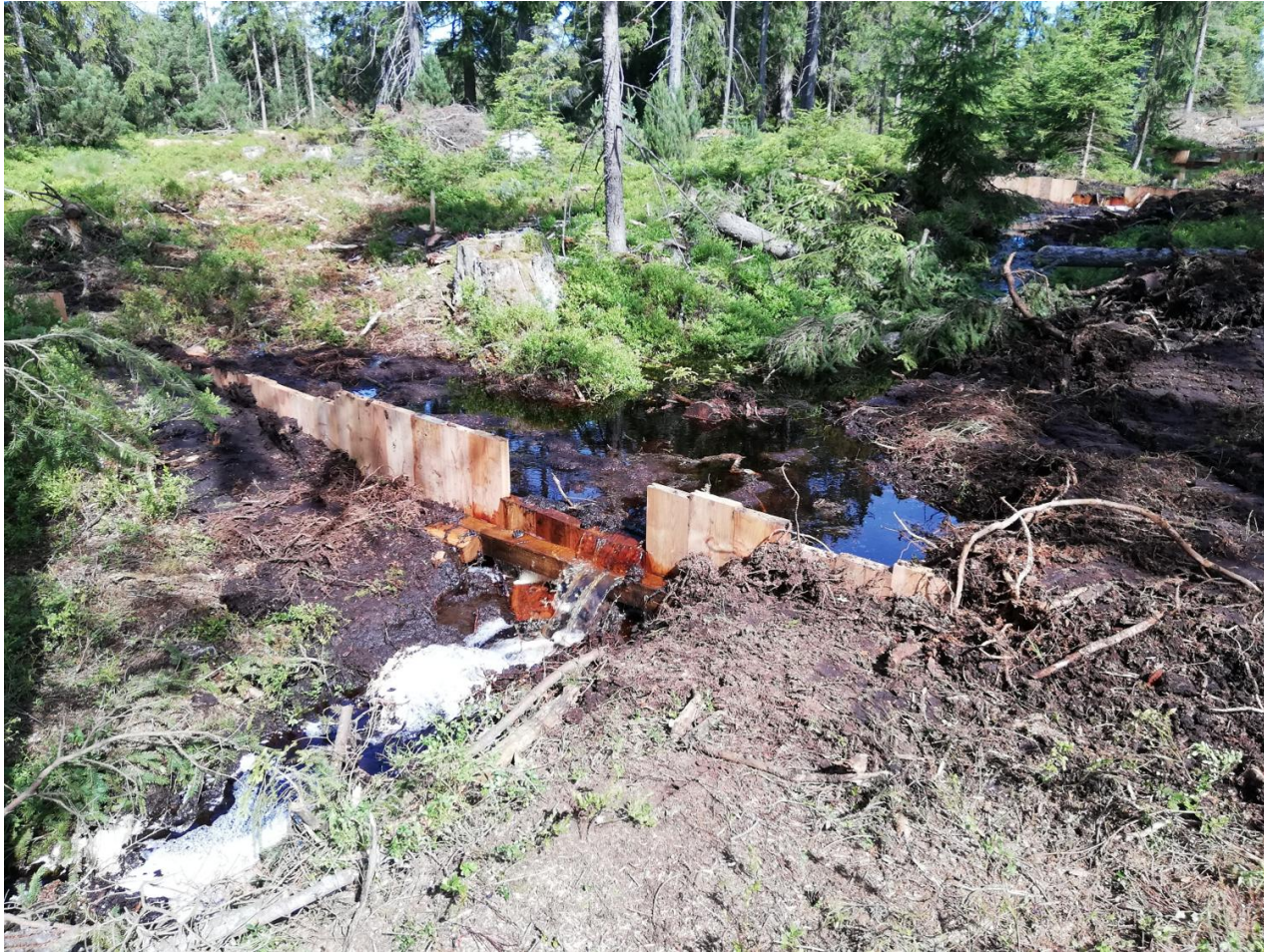
Fertige Holzspundwand
