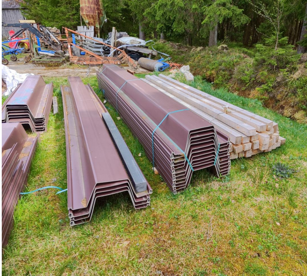
Zwischengelagerte Vinyl-Spundwände
