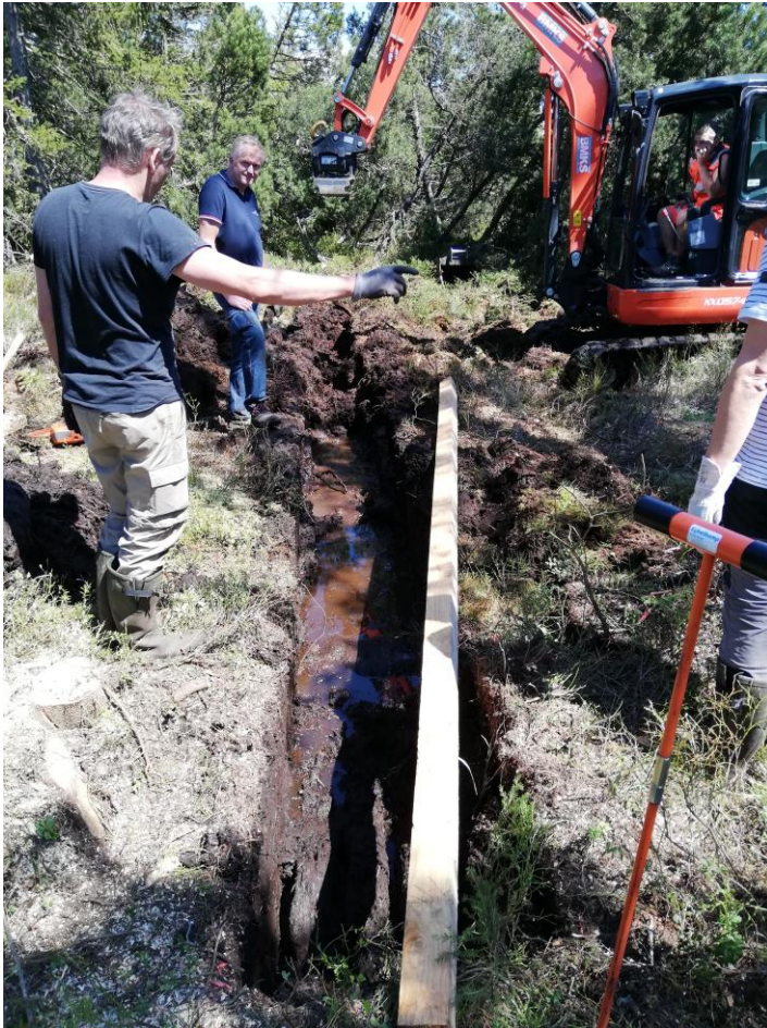
Aushub und erstes Kantholz
