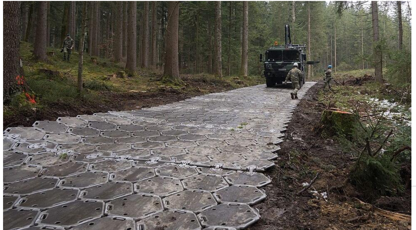
Zuwegung im Bereich Wildmoos (OÖ) mittels Faltstraßen; Österr. Bundesheer Bildquelle: Xaver Wimmer, Öbf
